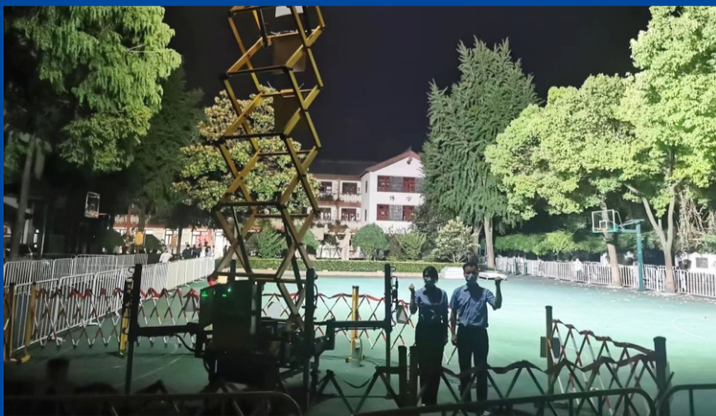
近期，南京疫情传播链仍在持续延长，当地全面组织多轮全员核酸检测，日夜作战。南京电网事业部协助供电公司现场提供夜间照明，共同保障核酸检测安全、有序进行。
