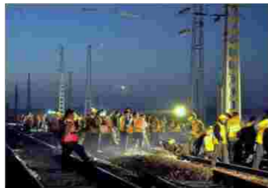
(铁路沿线抢险照明)
